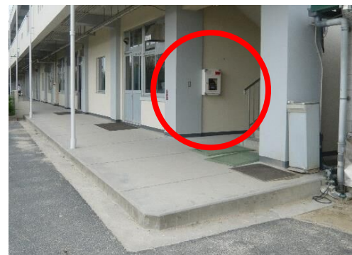
③ 建築科棟 1階東側 (テニスコート側)
