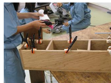
図11 補助板の取り付け
