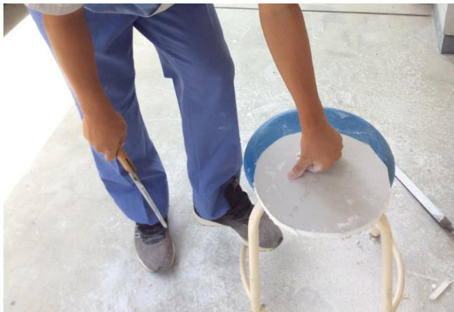
図 6 石膏ボードの加工
