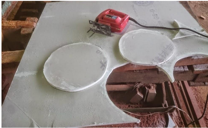
図 5 石膏ボードの切断
