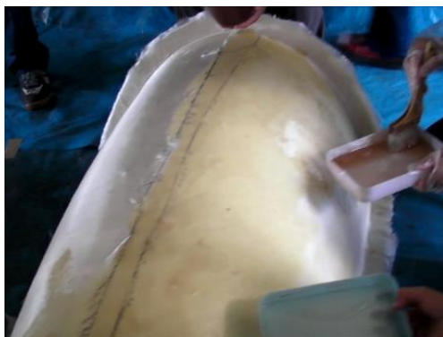
写真14 ガラス繊維を樹脂で貼付け中
