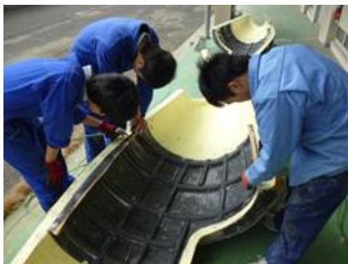
写真 19 補強材を炭素繊維で覆い強度向上
