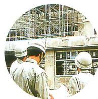
鉄筋コンクリート建築現場監督
