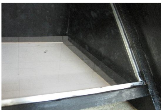
図3 アルミフレームの設置
